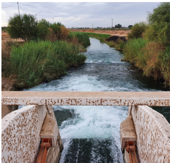
Canal de Riego en Distrito de Riego 014 Valle de Mexicali.
