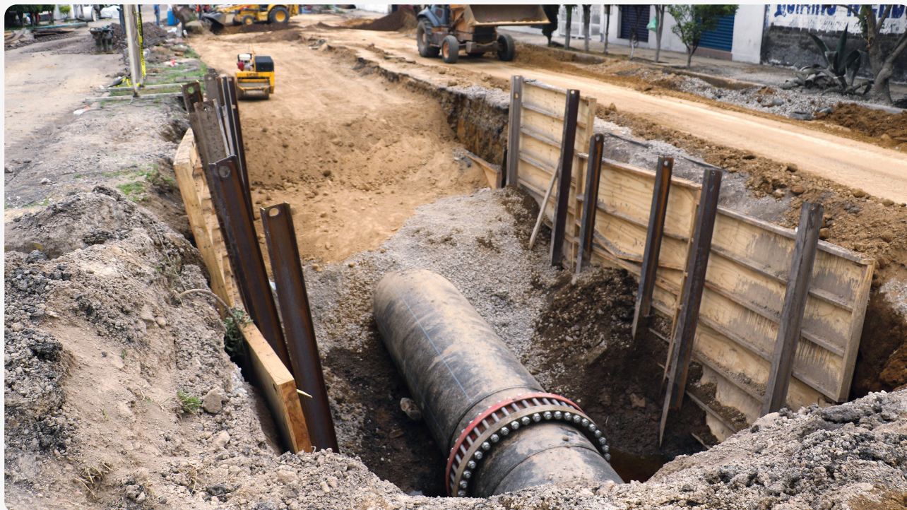
Figura 33. Rehabilitación de tubería.
