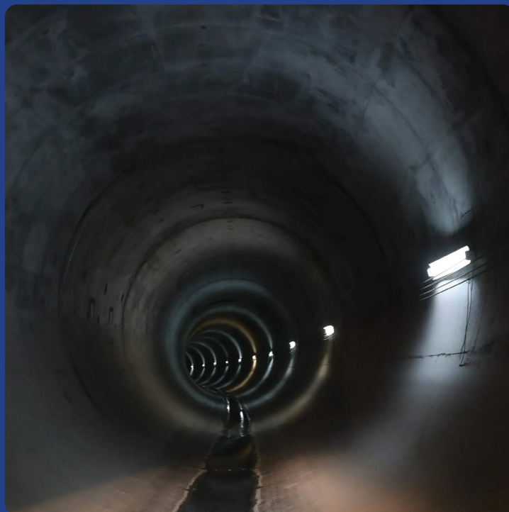
Figura 30. Túnel Emisor Oriente (TEO).
